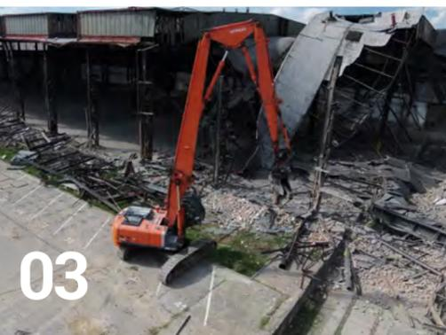
*Jsme vybaveni potřebnou technologií a zkušeným pracovním týmem pro realizaci velkých objemů demoličních prací včetně okamžité kontinuální likvidace vzniklého odpadu na skládku podle druhů a nebezpečnosti.*
